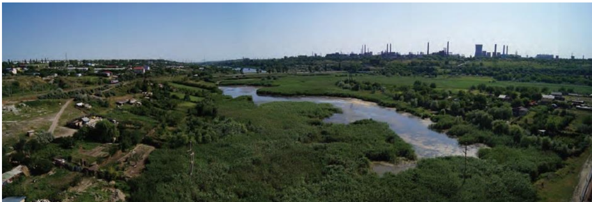
Intrarea din vest pe viaduct- Valea Cătușa
